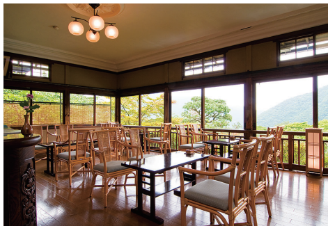
漆喰が使われたラウンジ「浅間」の天井
