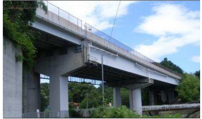
中村川橋の橋梁全景
